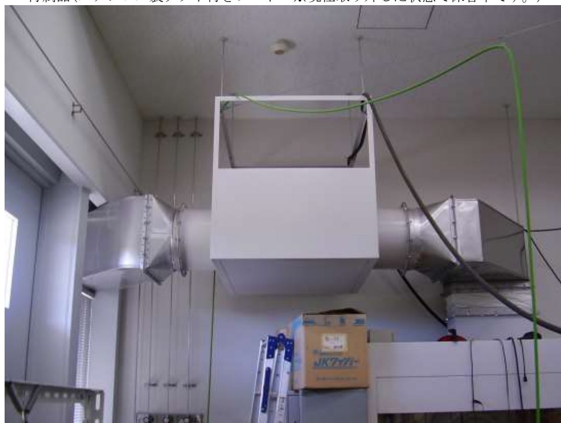
付属品(ステンレス製ダクト付きフード ※現在取り外した状態で保管中です。)
