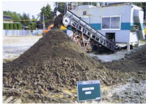
施工現場 (建設汚泥の固化)
