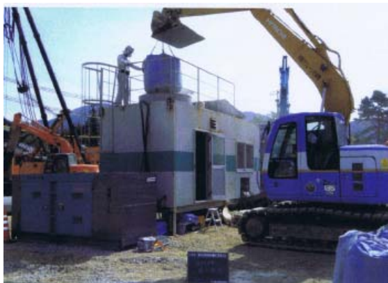
施工現場 (建設汚泥の固化)
