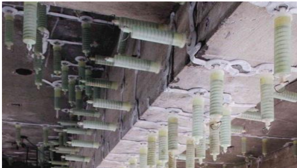
IPH工法 作業風景
