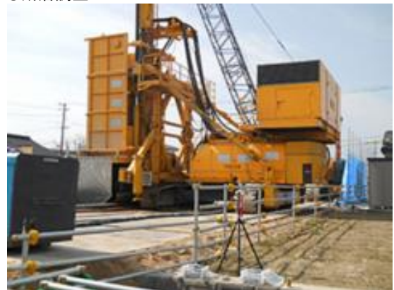
建設作業騒音・振動・周波数測定
