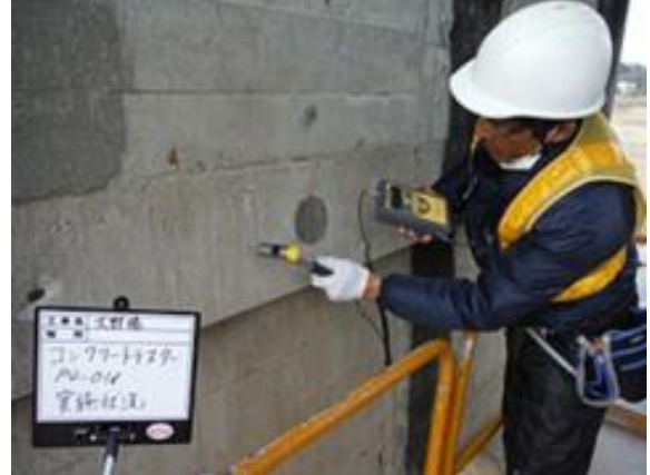
橋梁点検：コンクリートテスタによる圧縮強度推定
