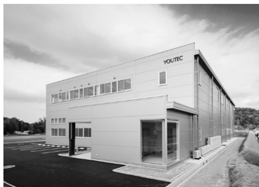
(株)ユーテック山口工場外観
