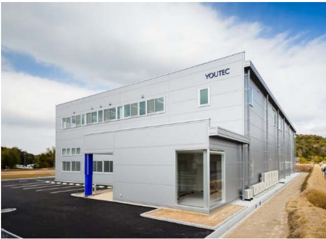
(株)ユーテック山口工場外観
