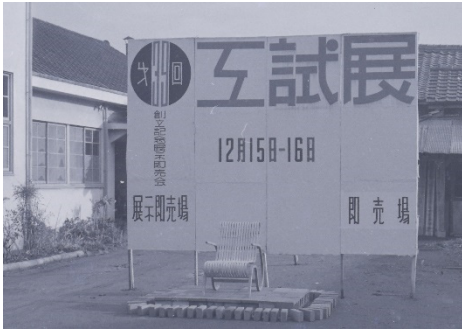
(b) 厩舎敷地内に建てられた看板
