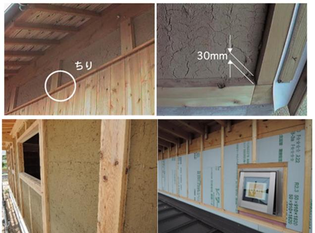
図3 土壁外気側充填断熱工法
