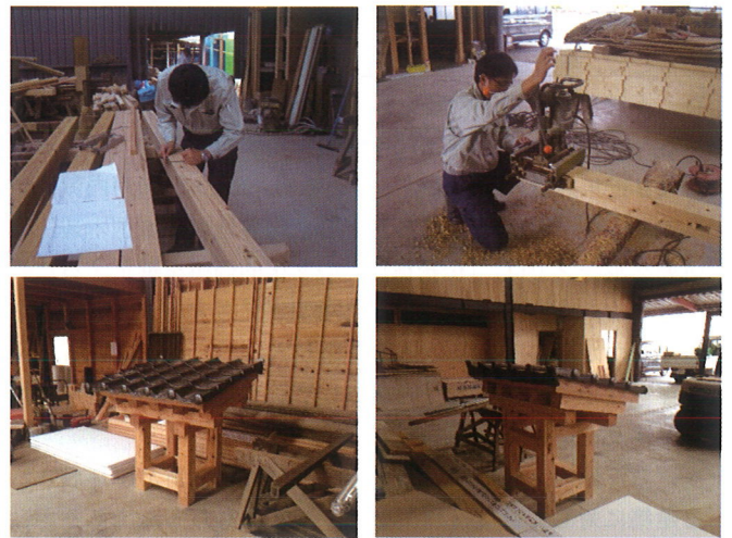
図2 セルフビルド建築施工可能性実験風景
