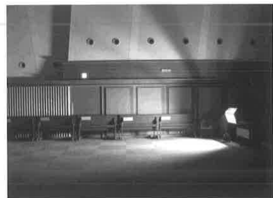
図13 高光束型器具の点灯状況
