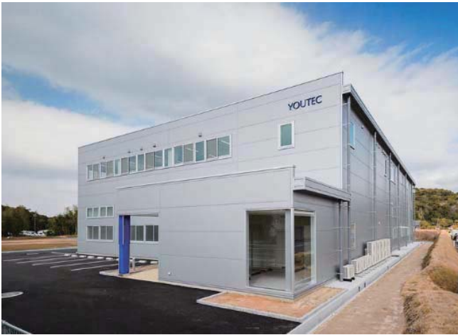
(株)ユーテック山口工場外観
