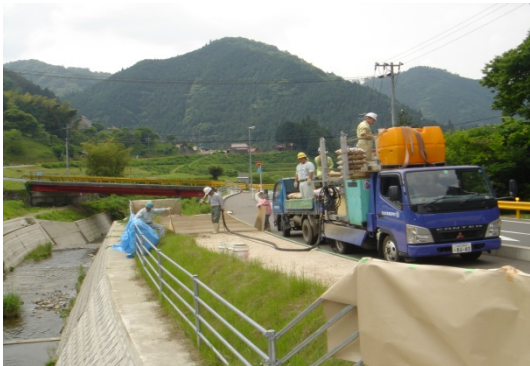
施工現場及び吹き付けプラント
