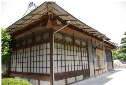
木造在来工法住宅の大きな開口部（窓）
