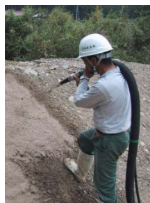
吹き付け作業
