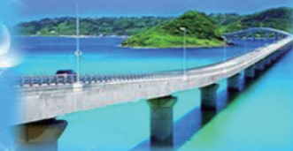
角島大橋（下関市）
