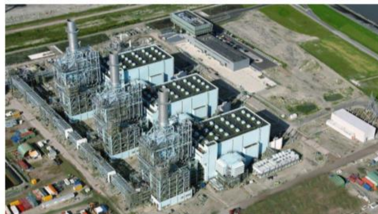
Vattenfall's gas power plant Magnum. (Photo: Koos Boertjens / Vattenfall)
